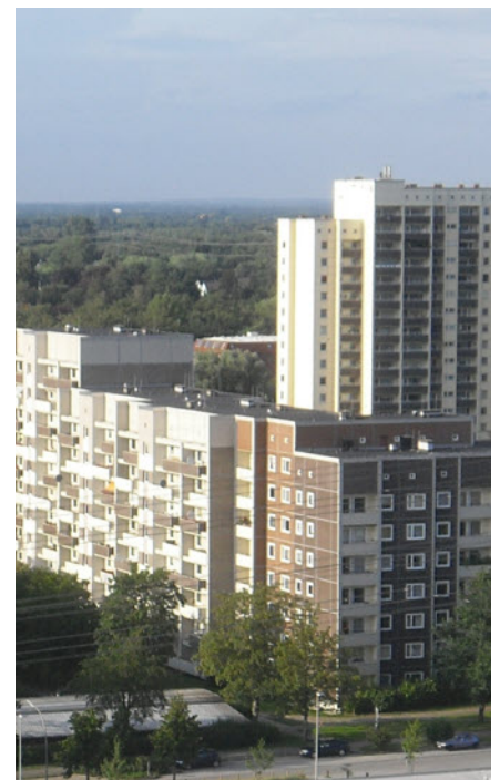
Wohnen ist kein Luxus sondern Menschenrecht. Deshalb setzt sich die SPD-Fraktion dafür ein, dass die Mietpreise nicht ins Uferlose steigen. Gerade in Quartieren wie dem Osdorfer Born (Foto) ist der Mieterschutz unbedingt notwendig
