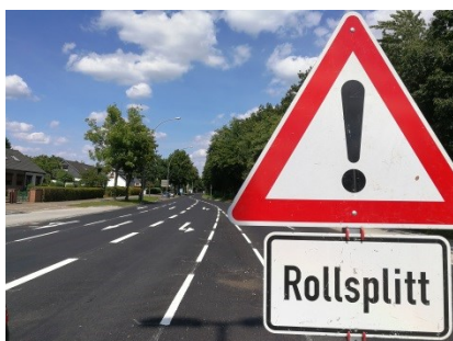
Der sanierte Straßenabschnitt Elbgaustraße am Farnhornweg
